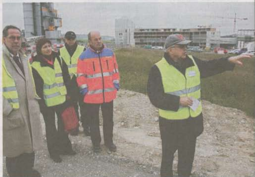
Eröffnung in einem Jahr: Eigentümervertreter Hans-Rudolf Schreiber (r., Neue Brünnen AG) erklärt Stapi Alexander Tschäppät und Gemeinderätin Regula Rytz die Baustelle. Bild: sat
