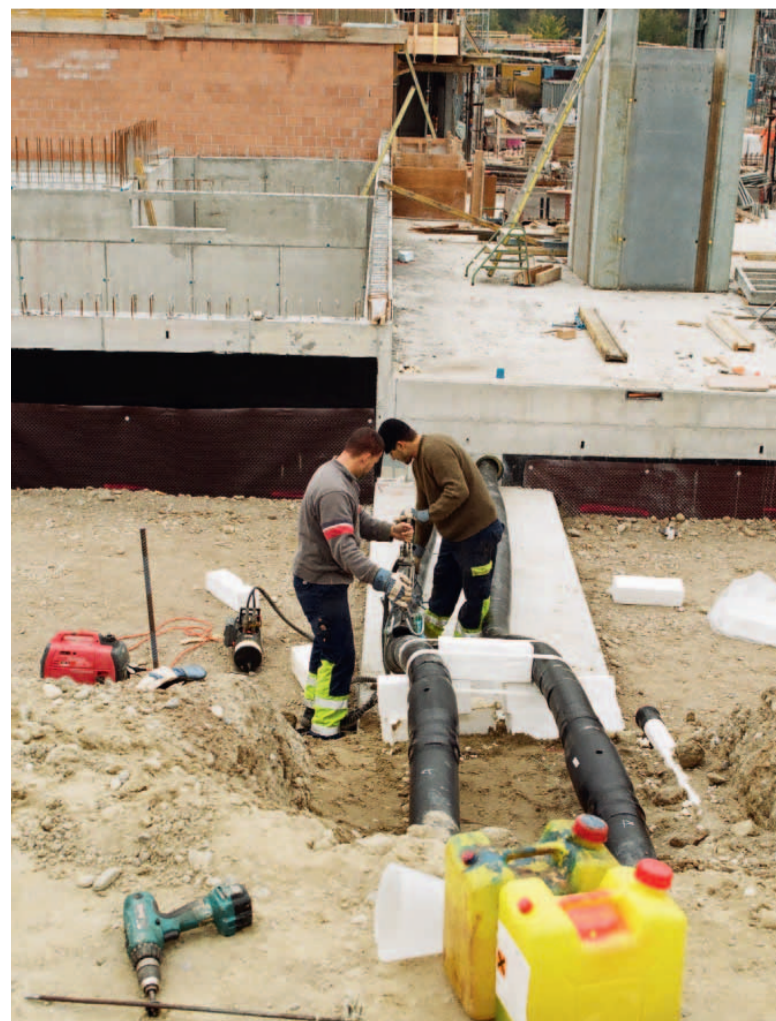
Leitungsverlegung zu den ersten Wohnüberbauungen: Die Häuser in Brünnen werden mit klimaschonender Fernwärme geheizt.
