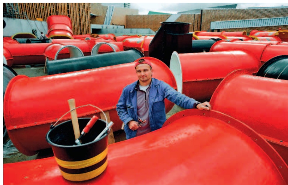
Fachmann Mario Öhrlein baut aus einzelnen Röhrenstücken die bis zu 175 Meter langen Wasserrutschbahnen des Erlebnisbades in Westside.
