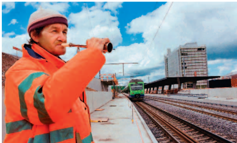
Keine Trinkpause: Die S-Bahnlinie wird bei laufendem Betrieb auf Doppelspur ausgebaut. Ein Arbeiter warnt vor durchfahrenden Zügen.
