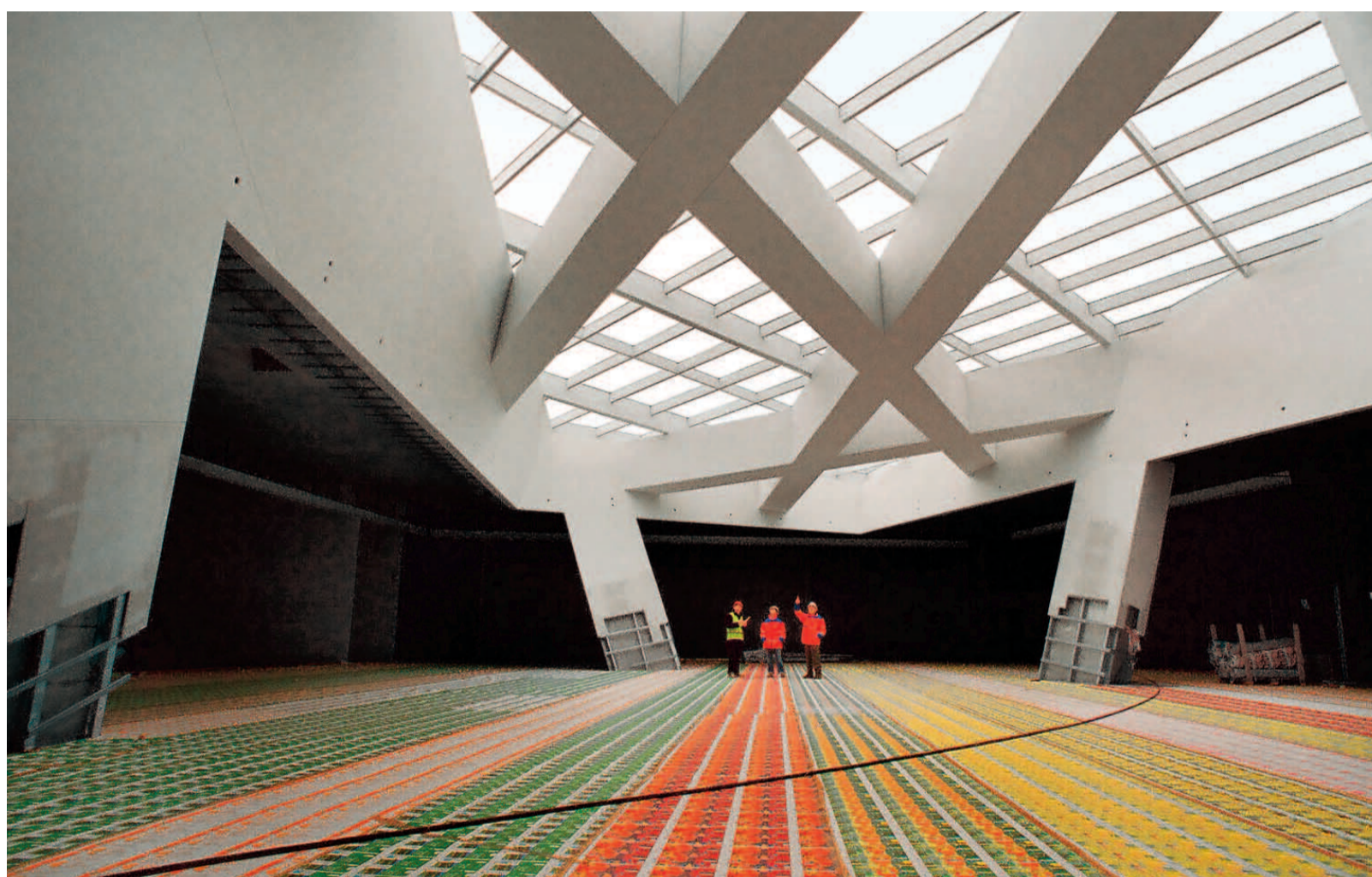
Es werde Licht: In Westside geht der Innenausbau voran. Daniel Libeskind's Architektur spielt mit dem Aussenlicht und bringt Besucherinnen und Besucher zum Staunen. Noch ist der darunter liegende Terrazzo-Boden durch eine Abdeckung geschützt.
