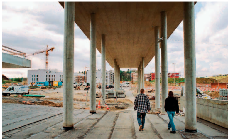
Der Weg ins neue Quartier: Vom erneuerten Ladenzentrum Gäbelbach führt ein gedeckter Fussgängerübergang ins neue Brünnenquartier.
