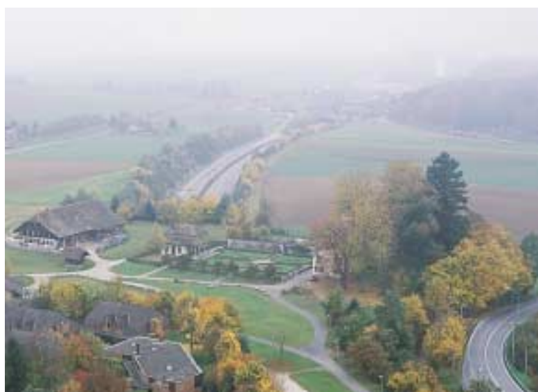
Sobald die Autobahn überdeckt ist, kann das Baufeld 6 (im Bild der Bereich rechts oberhalb der Murtenstrasse) überbaut werden. BILD: IRIS KREBS
