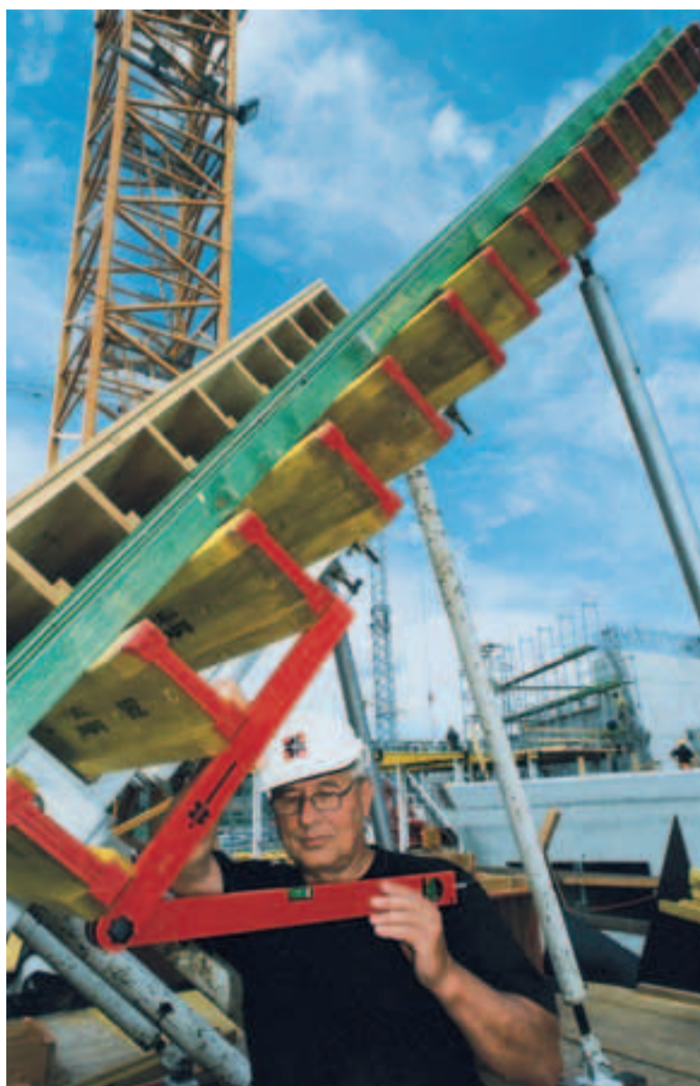
Genaueste Massarbeit: Joseph Röllin bei der Errichtung der Betonschalungen für Westside.
