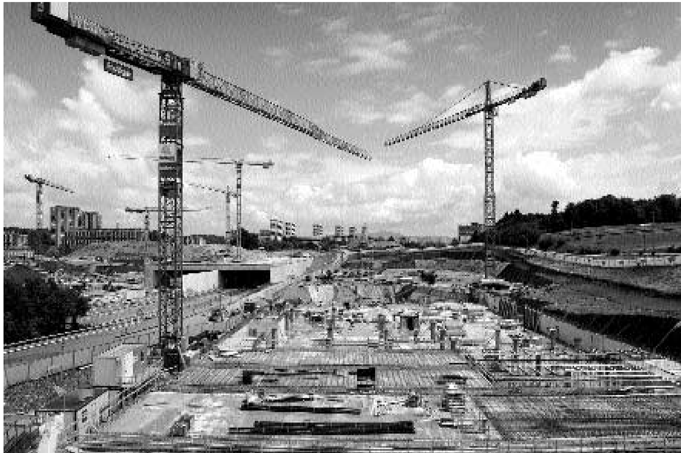
Brünnen: Heute eine Grossbaustelle, in einigen Jahren ein Quartier mit 2600 Einwohnern, die sich wohl fühlen sollen. VALÉRIE CHÉLAT
